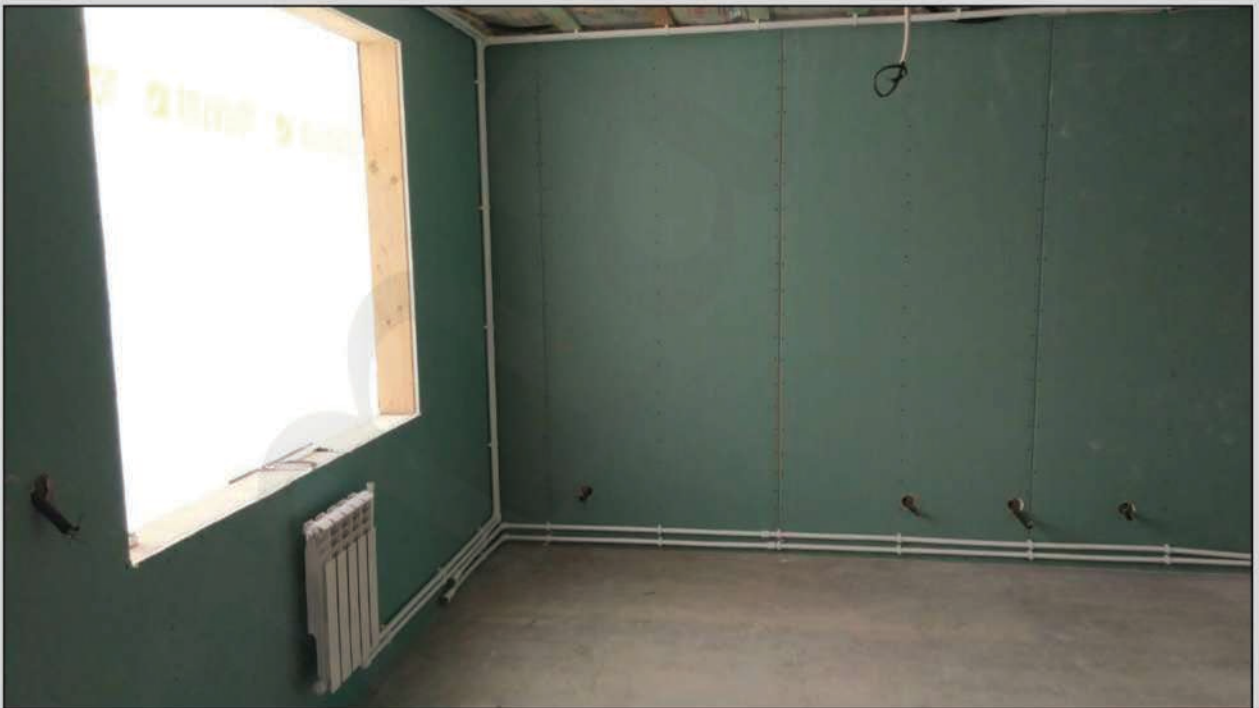
Рис.5 Перегородки с прокладкой коммуникаций
