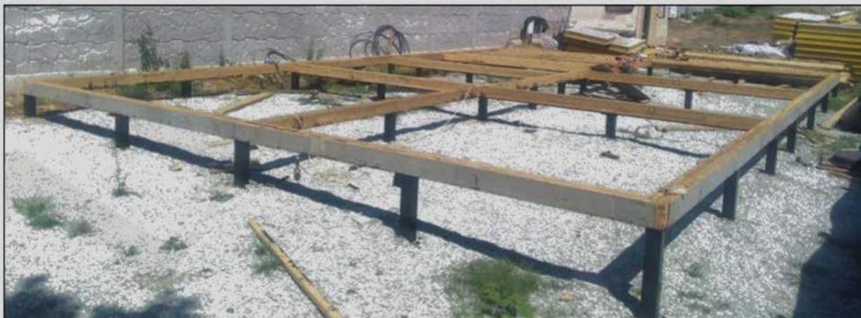
Рис.1 Ростверк в сборе
