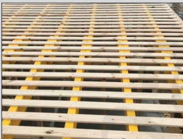
Рис. 7 Монтаж верхней обрешетки
