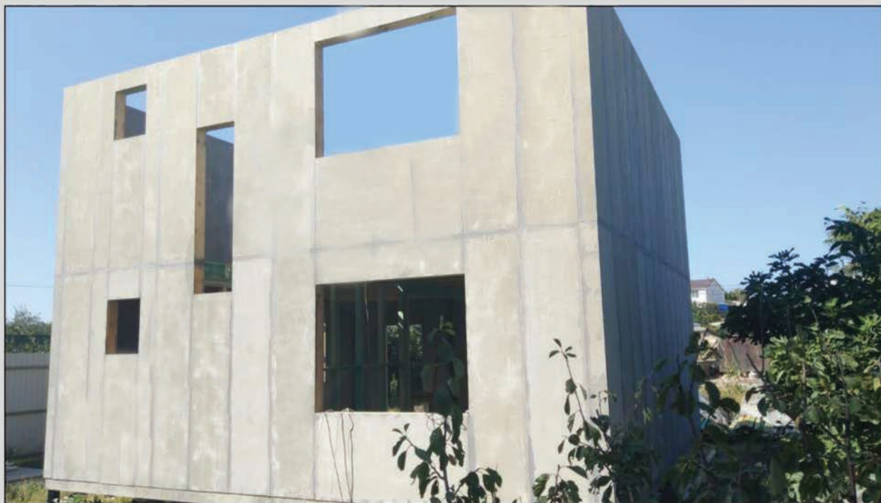
Рис.9 Стены 2х этажей в сборе
