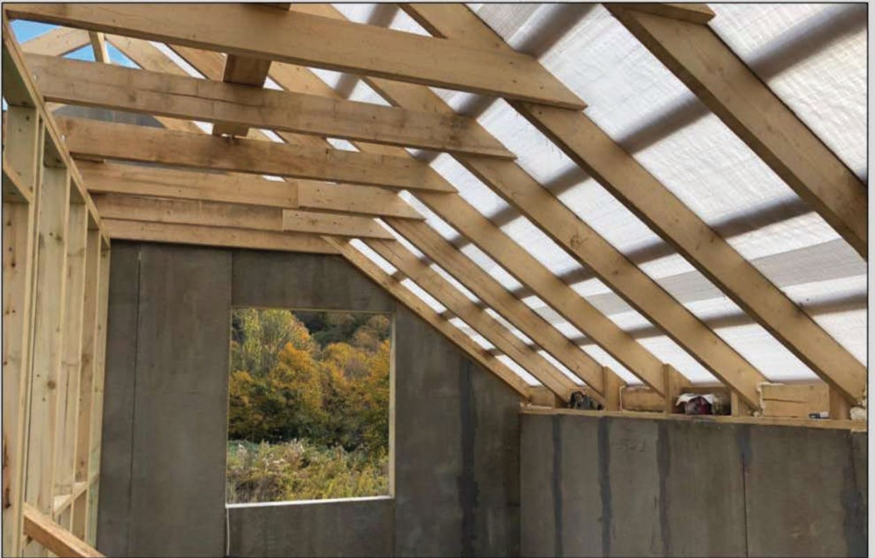
Рис. 11. Стропильная система мансардного типа
