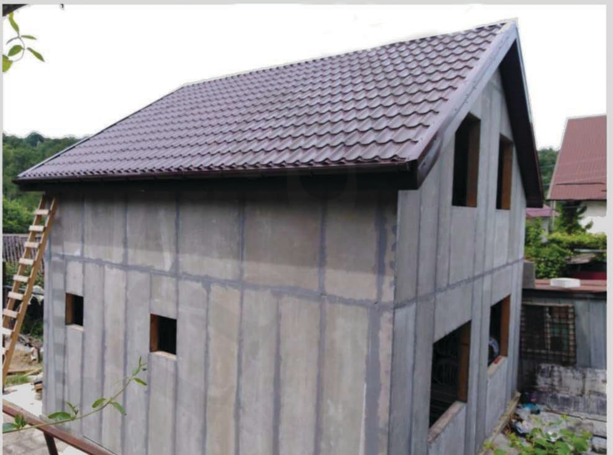
Рис. 17 Кровля с покрытием металлочерепицы
