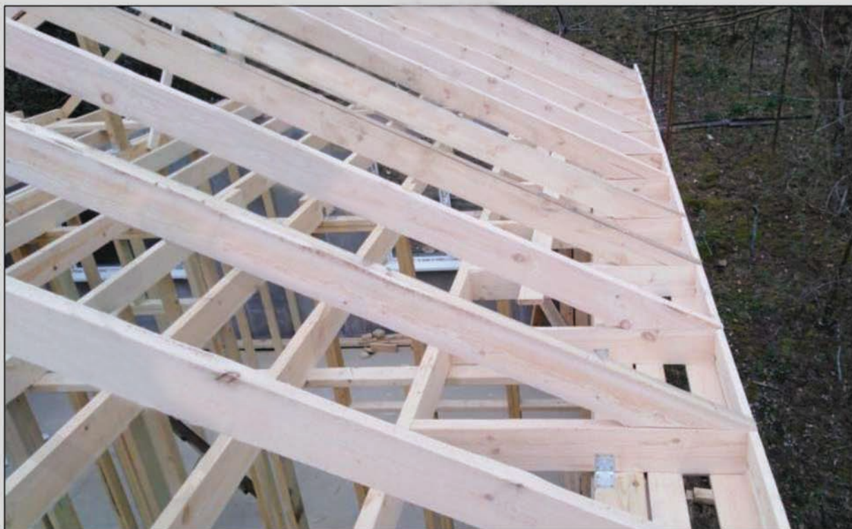
Рис 10. Чердачное перекрытие и стропильная система
