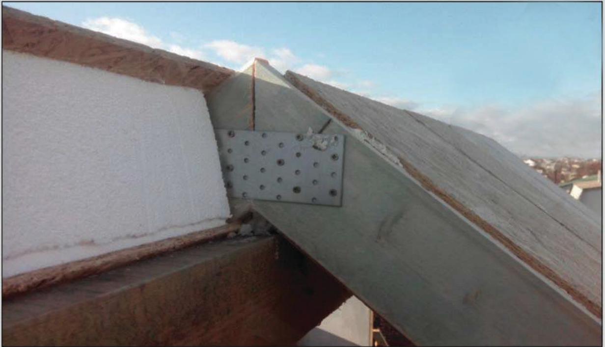
Рис. 14 Узел конькового стыка кровельных панелей
