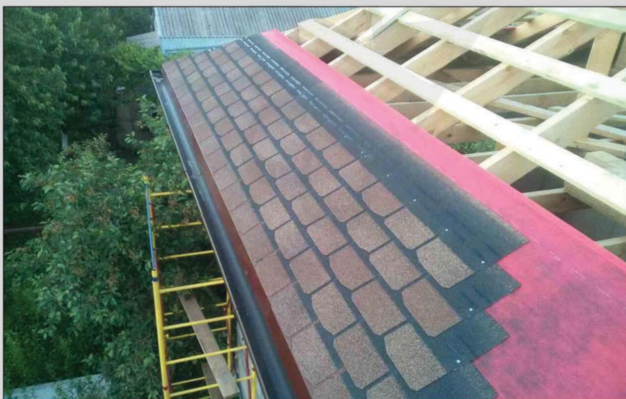
Рис. 13 Подкладочный ковер и гибкая черепица Шинглас
