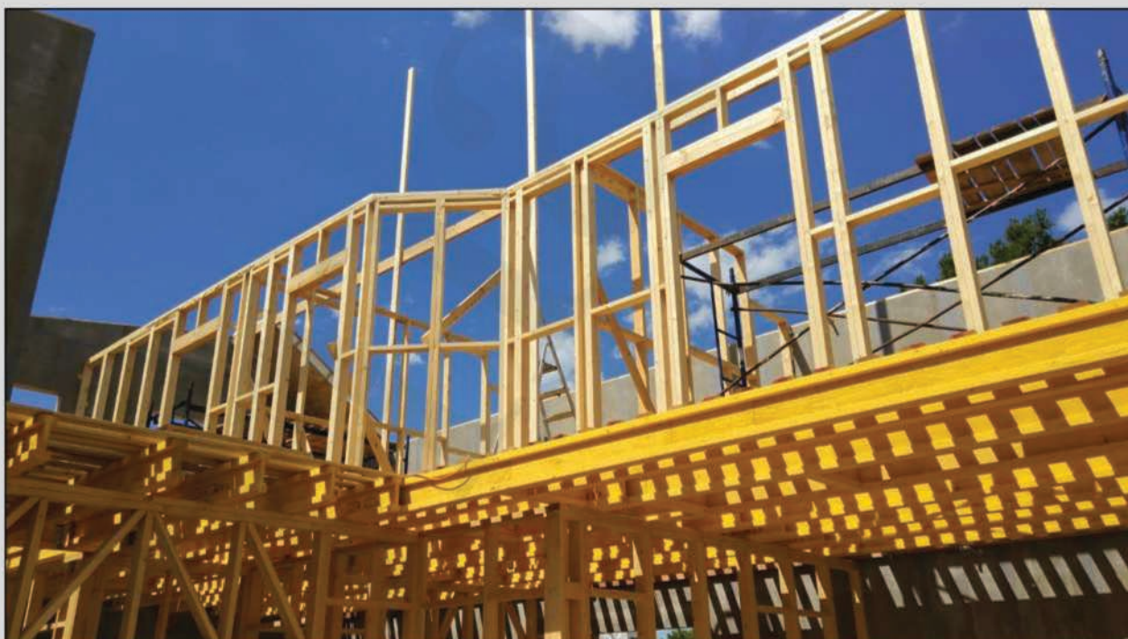
Рис.4 Каркасные перегородки
