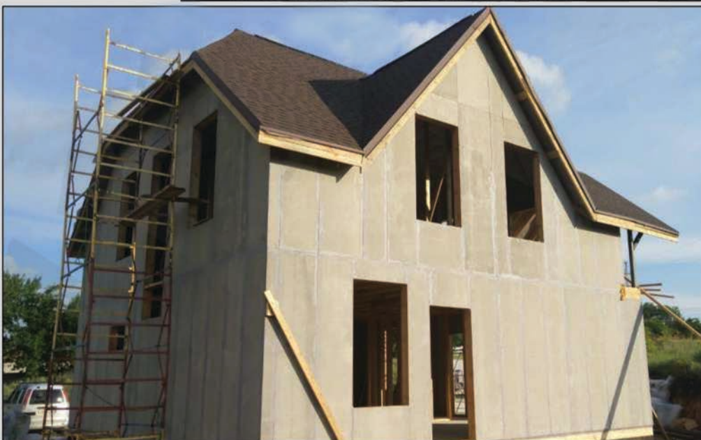
Рис. 16 Кровля с покрытием гибкой черепицы Шинглас
